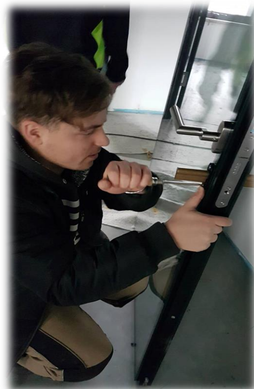
instalace zámku dveří
