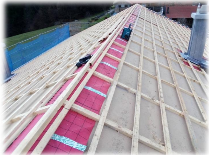
montáž střešních latí
