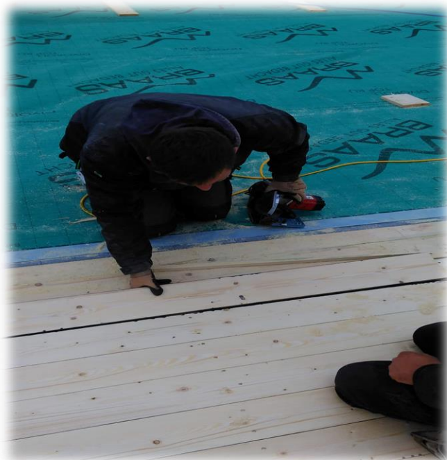
montáž střešní konstrukce
