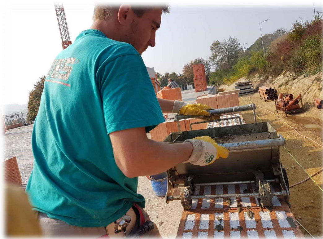
nanášení lepidla na zdivo
