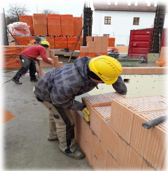
zdění obvodového zdiva
