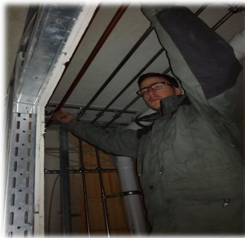
montáž rozvodů pro topení
