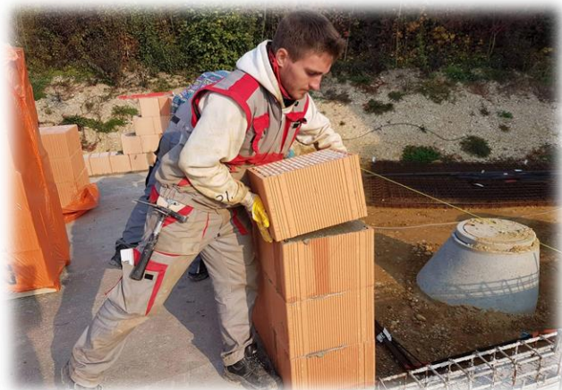
zdění obvodového zdiva
