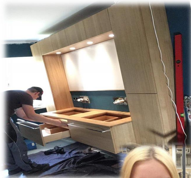
montáž koupelnové stěny
