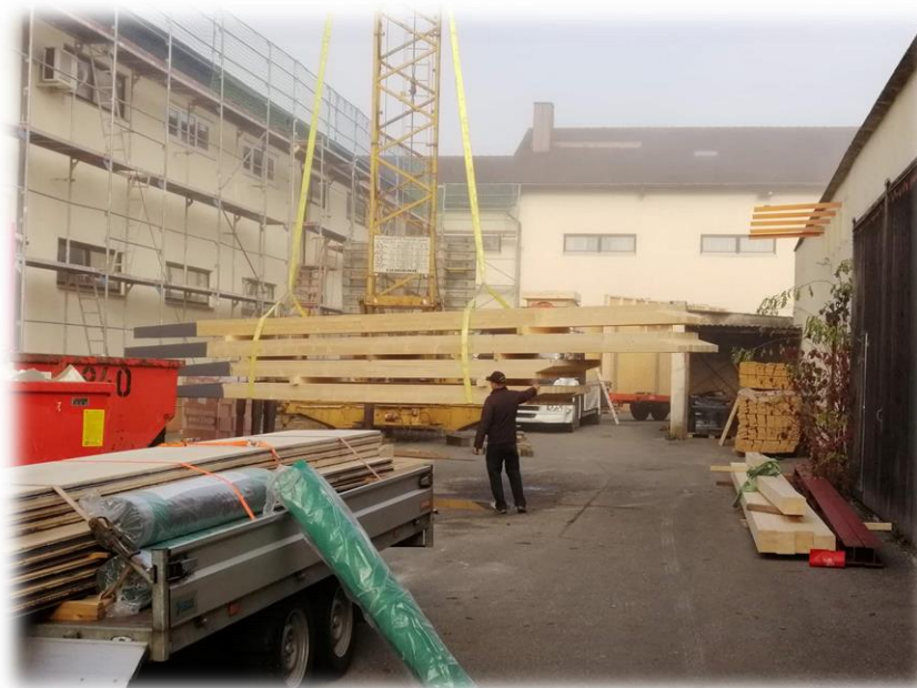
příprava střešní konstrukce
