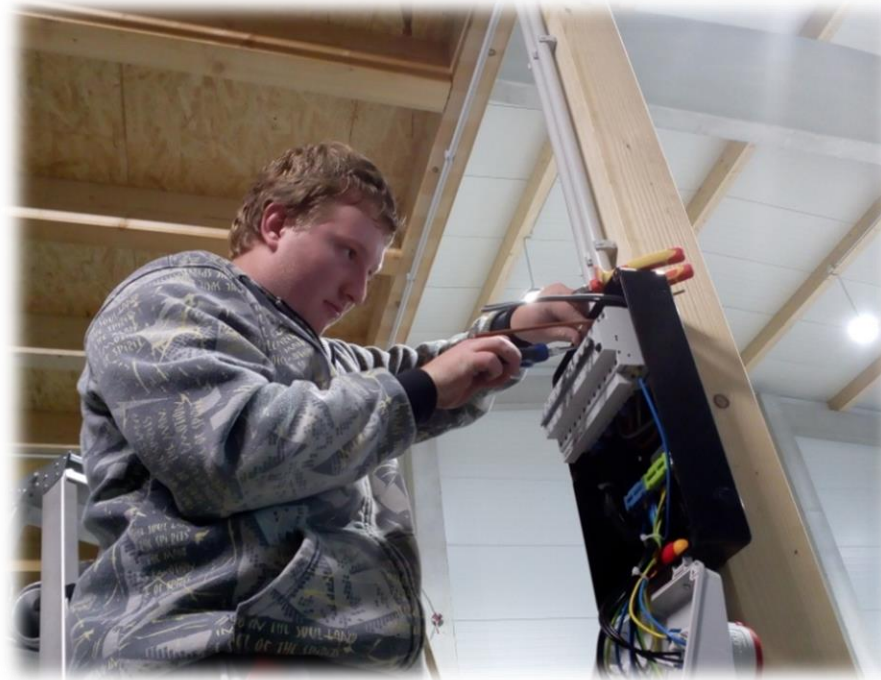
montáž rozvodné skříně
