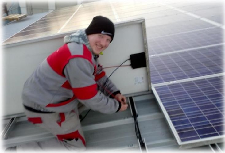
zapojení solárního panelu
