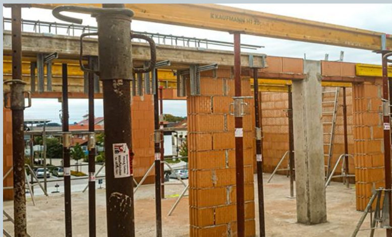
vztyčování podpor pro ŽB stropy
