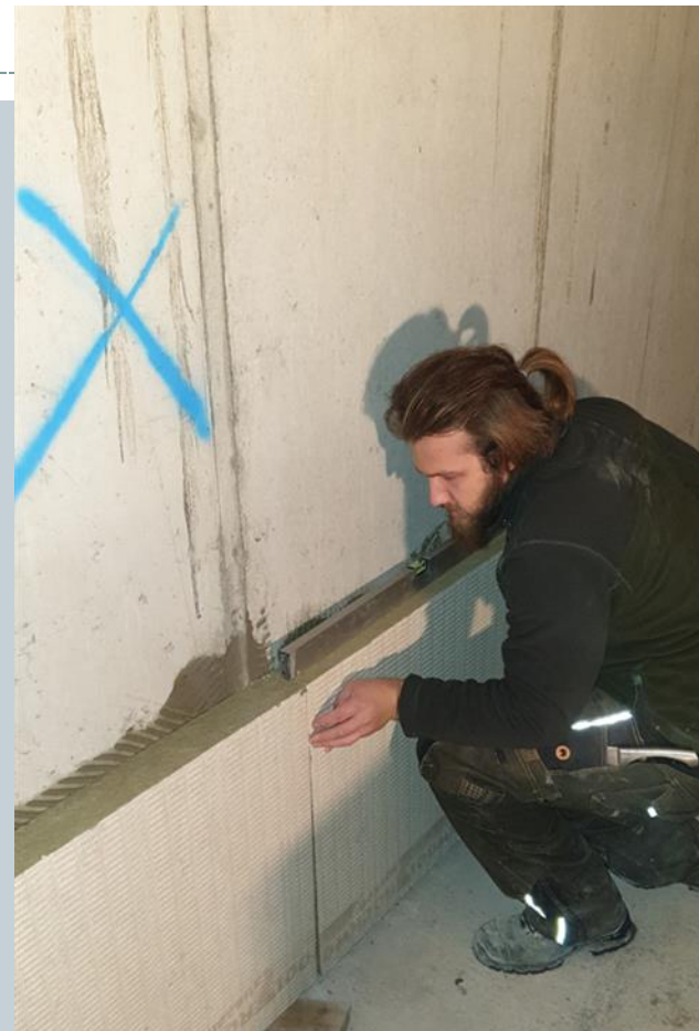
lepení minerální vaty v prostoru sklepa
